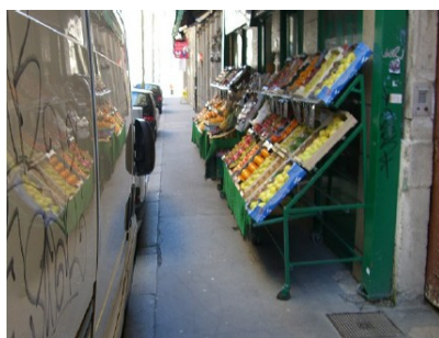
Étalage d'une épicerie qui ne laisse pas une largeur suffisante de cheminement (Source : Certu)
