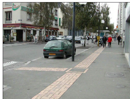
Pavage en briquettes pouvant servir d'aide à l'orientation pour les malvoyants et de délimitation de l'espace utilisable par les commerçants Ville de Lorient (Source : Certu)
